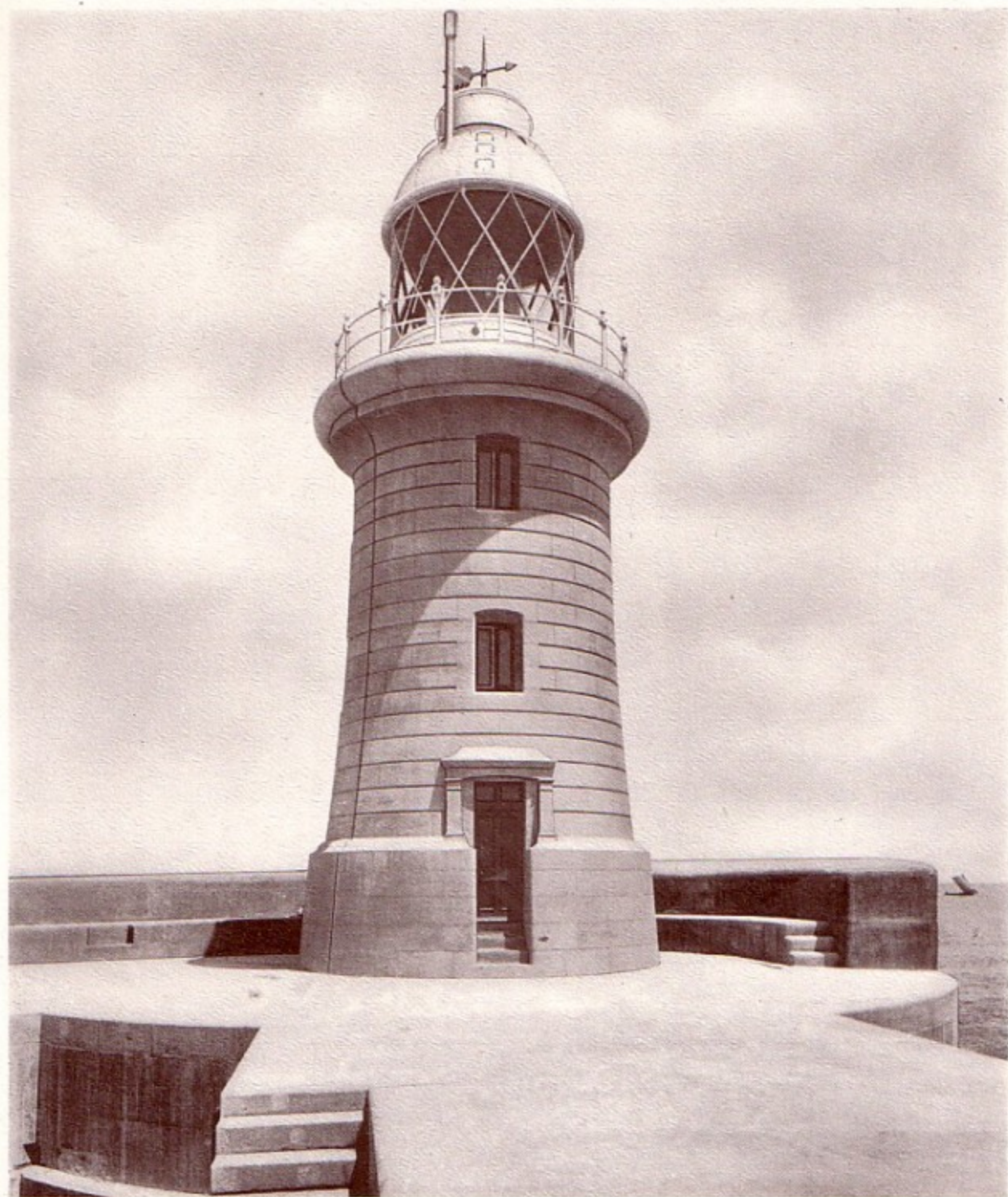
2ND ORDER LIGHT, IN 12FT. LANTERN, ERECTED ON MASONRY TOWER. Feu de 2e ordre, dans lanterne de 12 pieds, monté sur tour en maçonnerie. Fanal de 2º orden, dentro de linterna de 12 piés, montada sobre torre de mampostería
